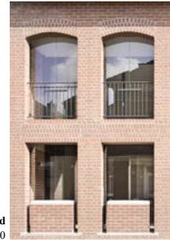
Wohngebäude im Wigbold Münster, 2020
